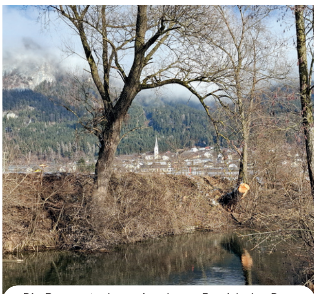
Die Baumentnahmen im oberen Bereich des Drau-Altarms wurden erfolgreich abgeschlossen.
